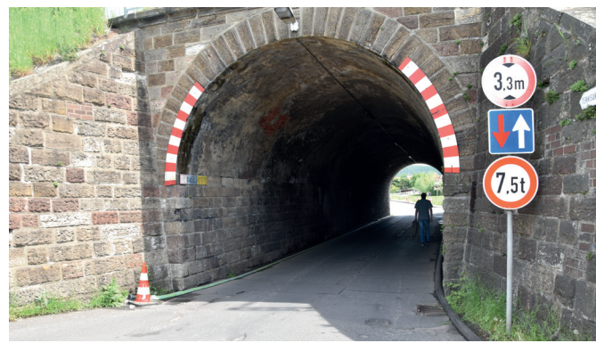
Einmündung des Tunnels Richtung Göttinger Bogen
