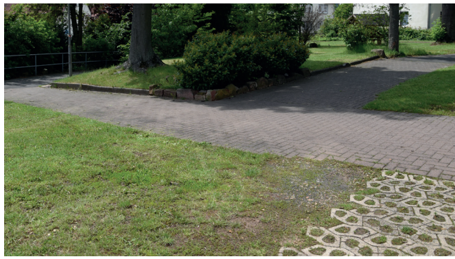
schlechte Oberflächen der Wege
