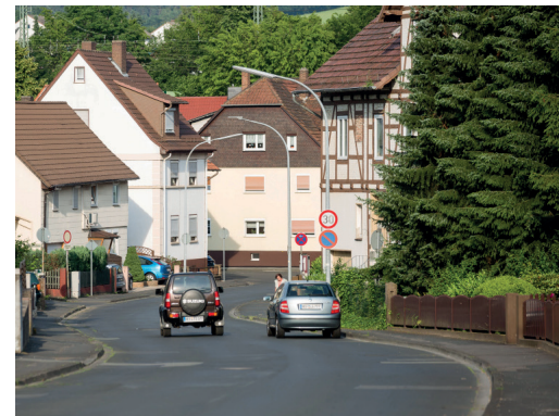
Rotenburger Straße / Zustand vor grund-
