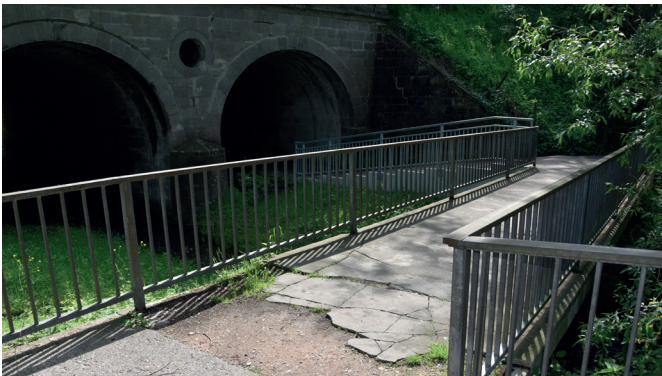
Brücke zur Mende-Anlage
