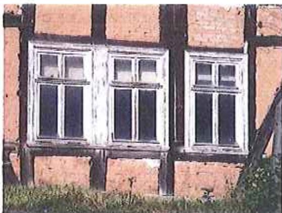
Abbildung 64: Fenster mit T-Stock und Klappläden, Iba/Gilfershausen
