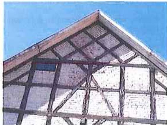
Abbildung 55: Modernes Fachwerk mit Backstein-Ausmauerung (Gründerzeit), Iba
