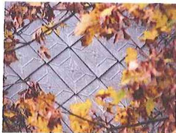
Abbildung 62: Typischer aber seltener Blech-Schindelbehang mit kleinteiligen Schablonen und Bordüre, Iba
