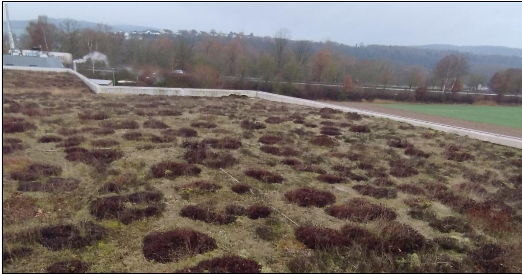
Abb. 3-3: Begrünte Hälfte Flachdach Herkulesmarkt
