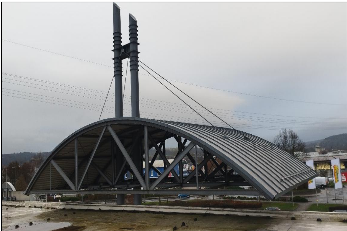
Abb. 4-3: Metallstruktur Vordach Eingangsbereich
